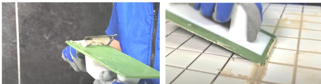
Рис. 27. Заполнение швов затиркой при помощи резинового шпателя
