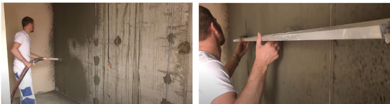
Рис. 20. Схема нанесения обрызга на поверхность и разравнивание правилами образовавшихся наплывов
