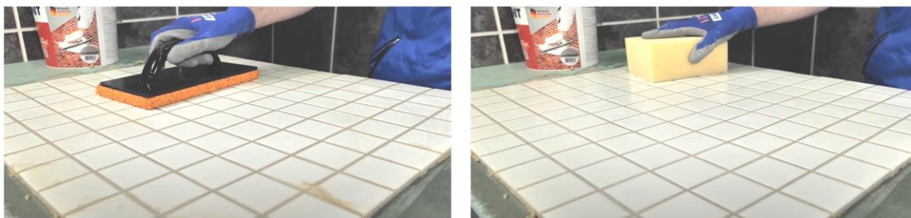
Рис. 29. Диагональными движениями шпателя убрать с поверхности плитки излишки затирки
